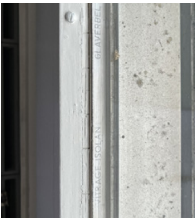
Abbildung 10 (oben): Bei diesen Fenstern, eingebaut als Einfachglas mit Kittfuge, wird ein zerstörungsfreier Ausbau nicht möglich sein.
