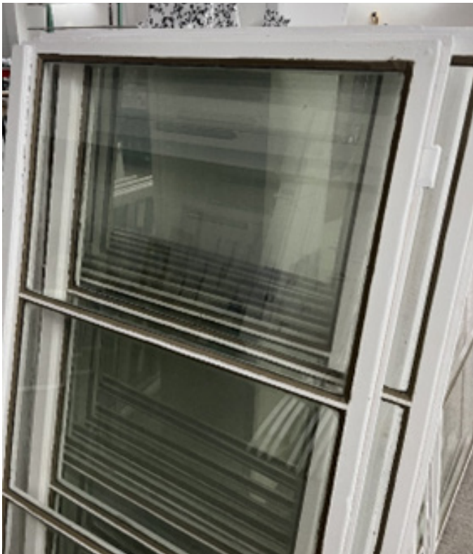
Abbildung 10 (oben): Bei diesen Fenstern, eingebaut als Einfachglas mit Kittfuge, wird ein zerstörungsfreier Ausbau nicht möglich sein.
