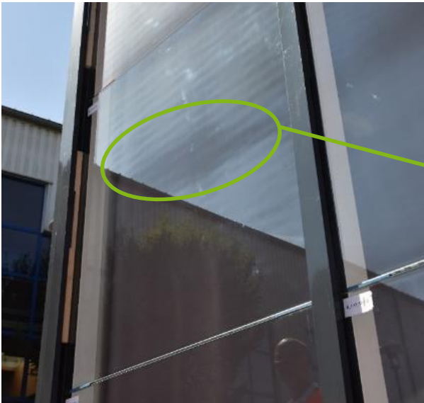
Bild 1 Anisotropien unter (teil)-polarisiertem Tageslicht am 01.08.2017 (Quelle: Hochschule München)
